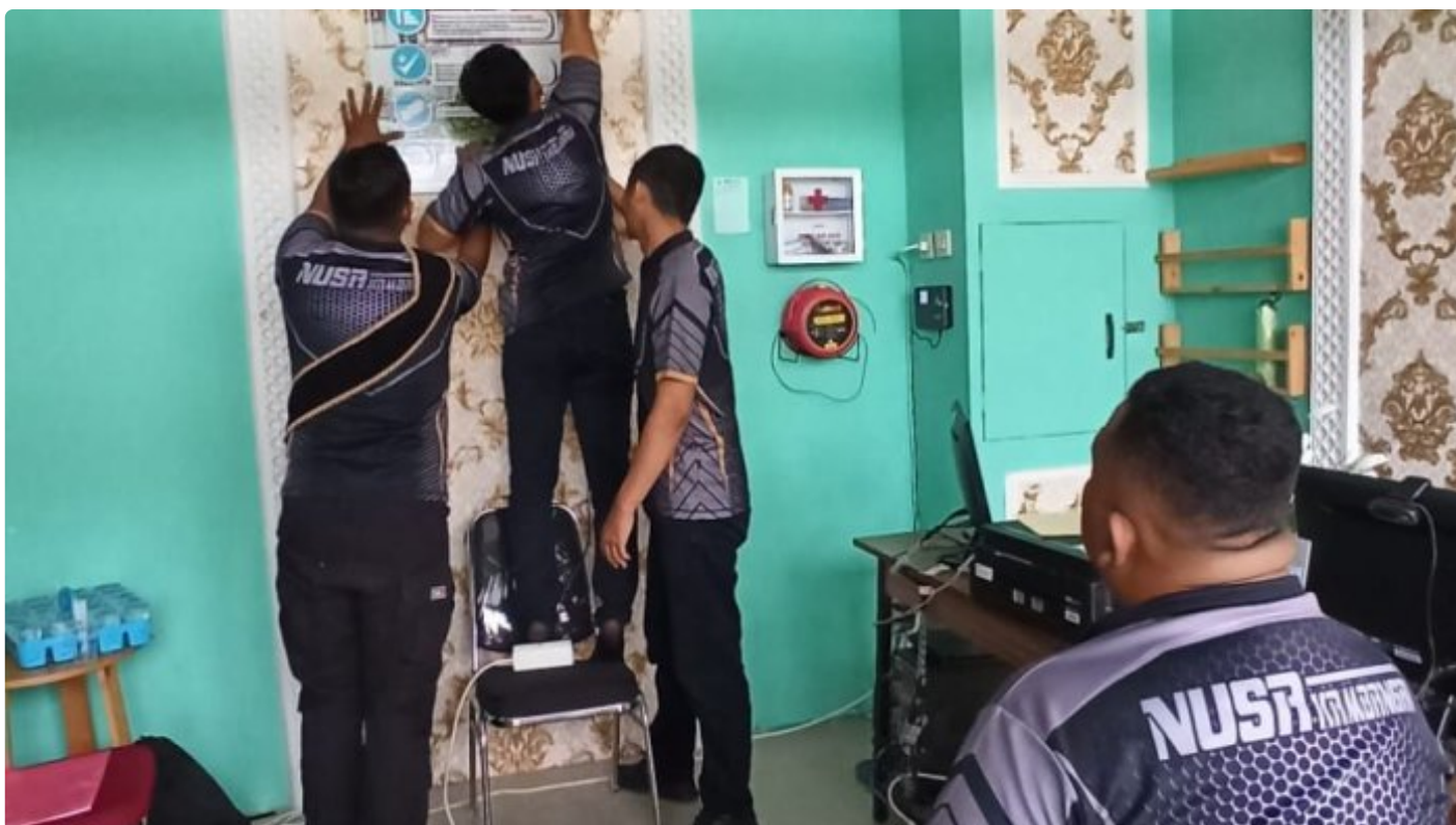
Kabapas dan Staff Renovasi Ruang Baladewa
