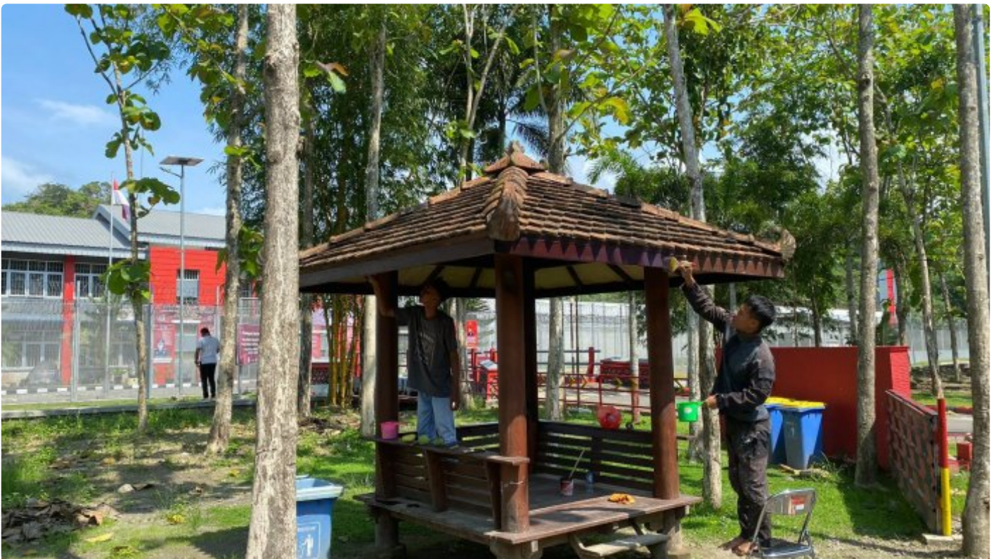
Pengecatan Pos Pengamanan, Dalam Rangka Perawatan Sarpras Lapas Pasir Putih Nusakambangan
